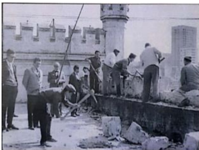
Demolición de la Penitenciaría Nacional AGN, 1961
