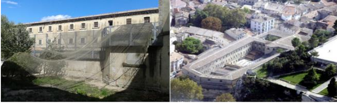
Fotografías del exterior de la prisión © Angélique Surel ( https://www.ledauphine.com/actualite/2019/03/04/ancienne-prison-transformee-en-logements-a-avignon-les-travaux-lances-cette-semaine )
